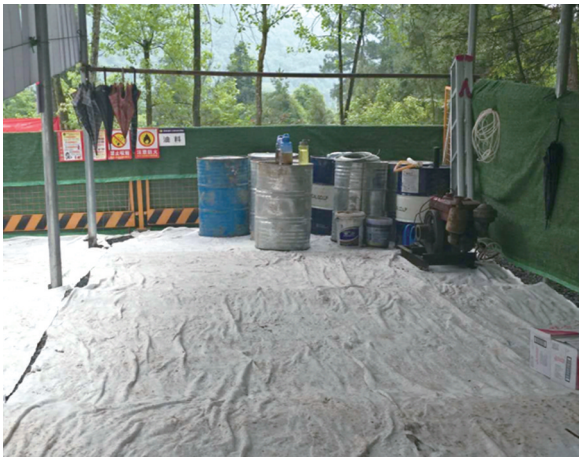
图 1 土工布铺设及辅助工具集中摆放点
