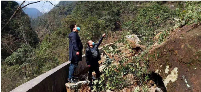
环境院铜仁分院开展梵净山旅游公路崩塌应急调查
