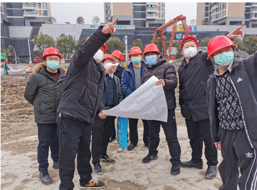
114地质队助力防污净水攻坚战，在遵义市狮子桥片区开展城市棚户区改造工程勘察施工。（方尚武 摄）
