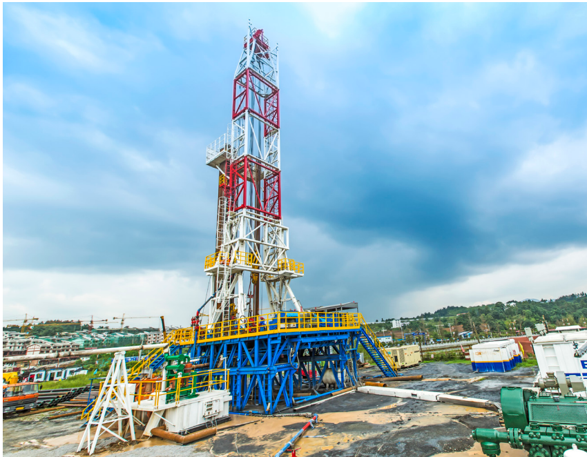
我局实施的地热井施工现场
