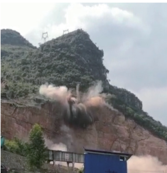
兴义马岭龙井大滑坡治理项目现场。
